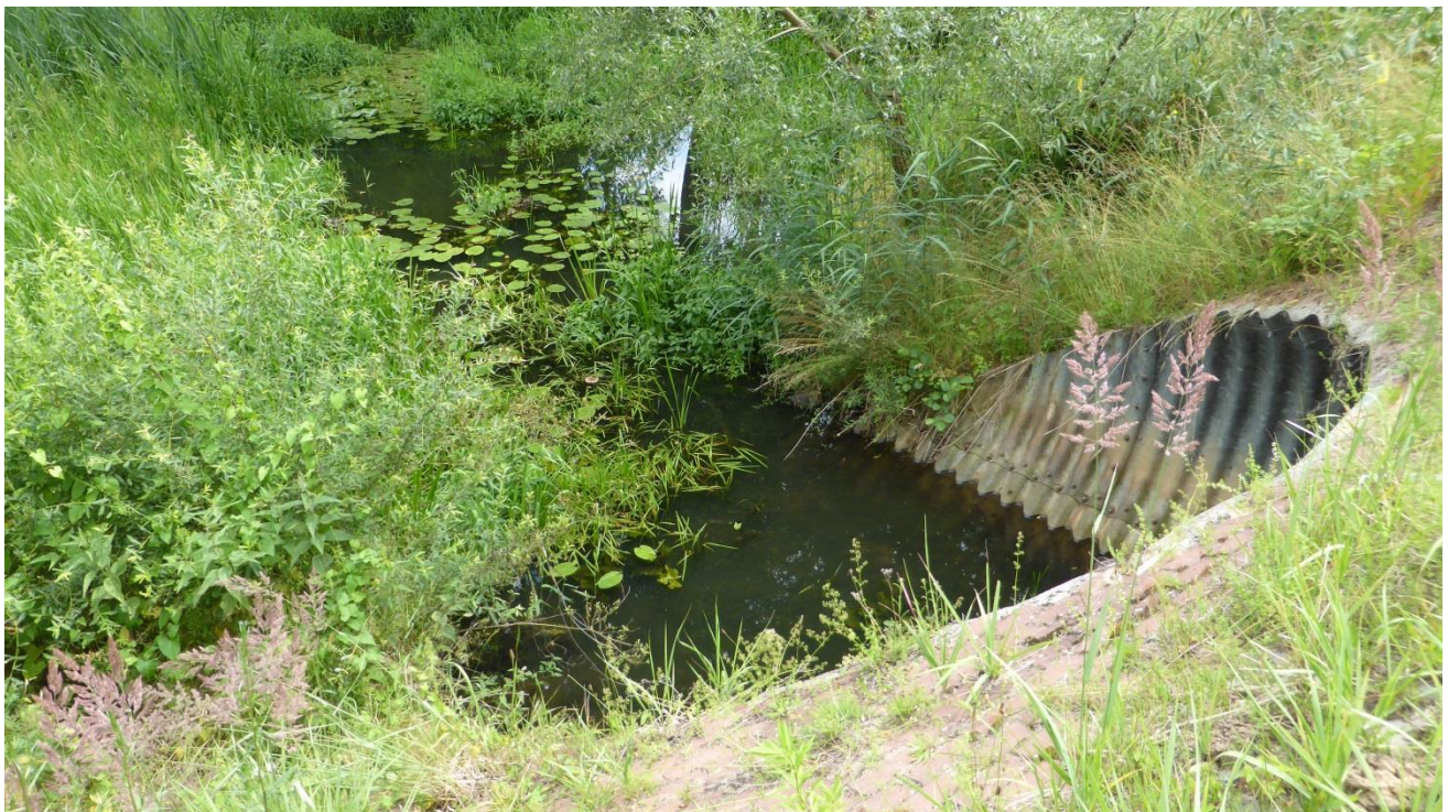
Przepust drogowy na Kanale Pomorskim w m. Brody
