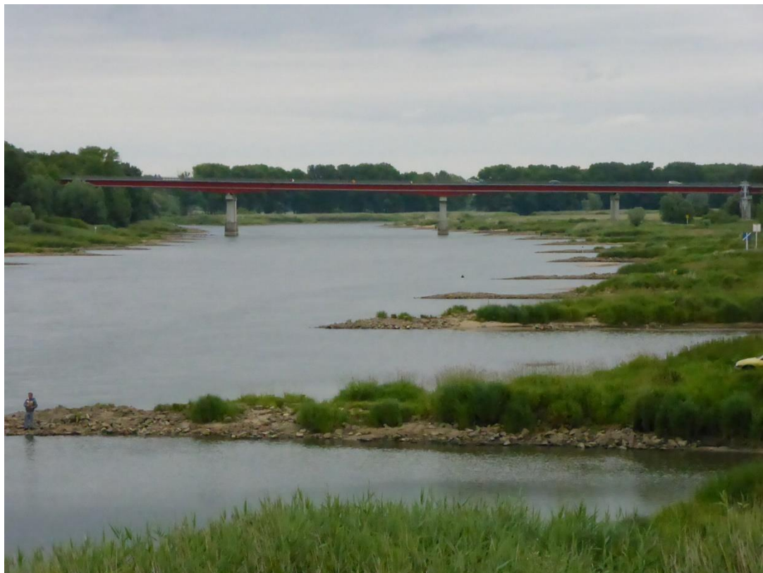
Widok ze starego mostu na nową obwodnicę w Cigacicach
