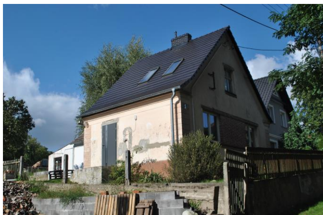
Dom, widok od SW
