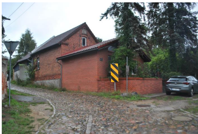
Budynek , widok . od SW
