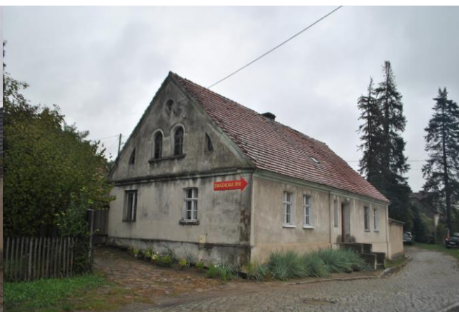
Dom, widok . od SW
