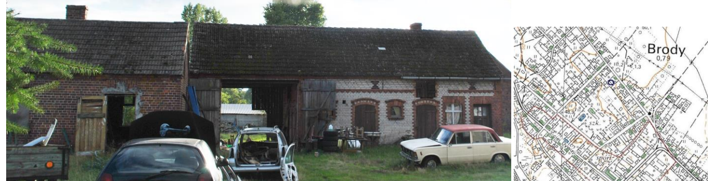
Budynek gospodarczy, widok części północnej
