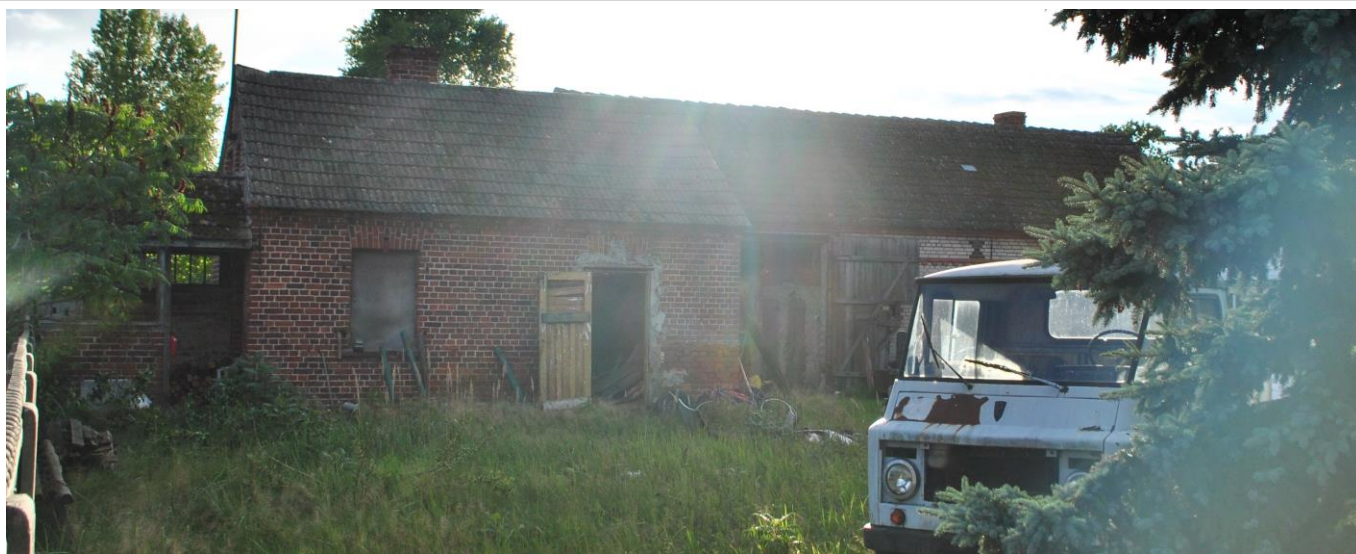
Budynek gospodarczy, widok części południowej
