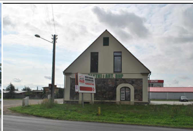
Budynek, widok od N
