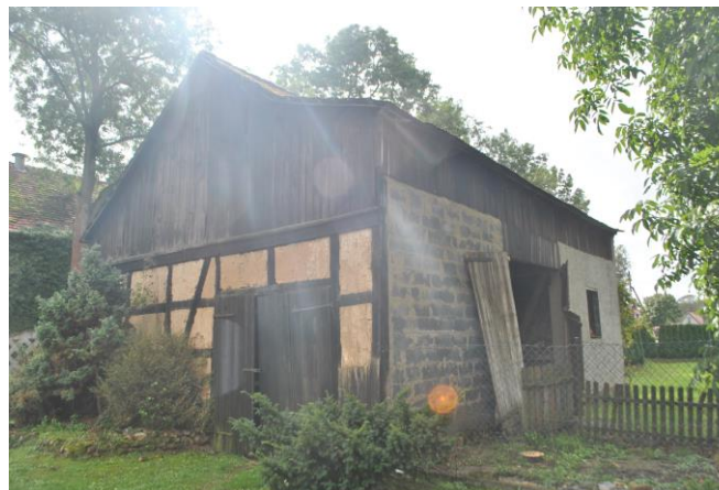
Budynek, widok od N
