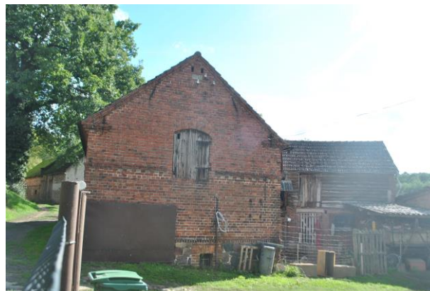
Budynek, widok od W
