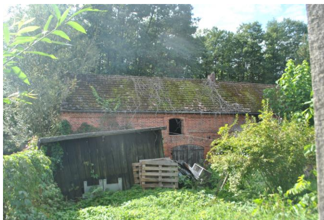
Budynek, widok od N
