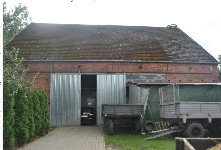
Budynek I, widok od N
