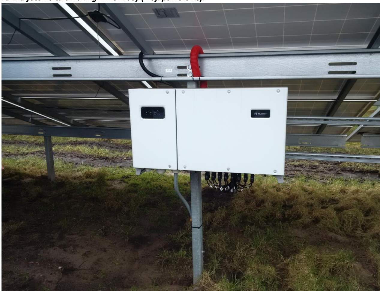
Rysunek 16 Inwerter o mocy 42 kW zamocowany na konstrukcji nośnej paneli fotowoltaicznych
