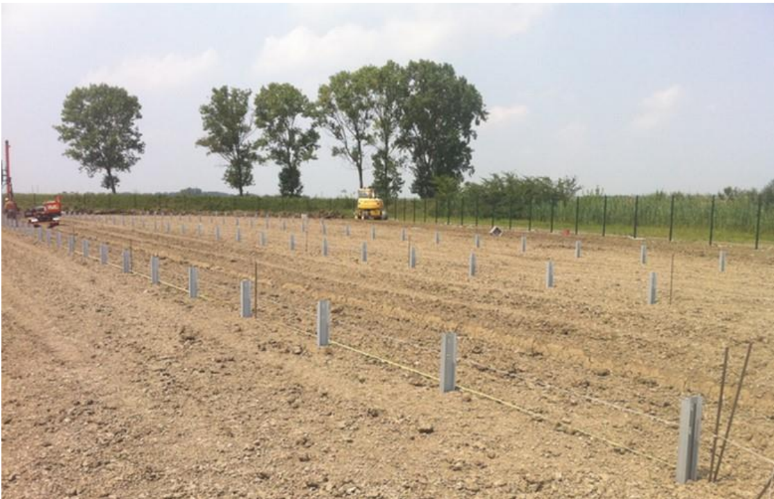
Rysunek 22 Profile nośne wbite w rodzimy grunt
