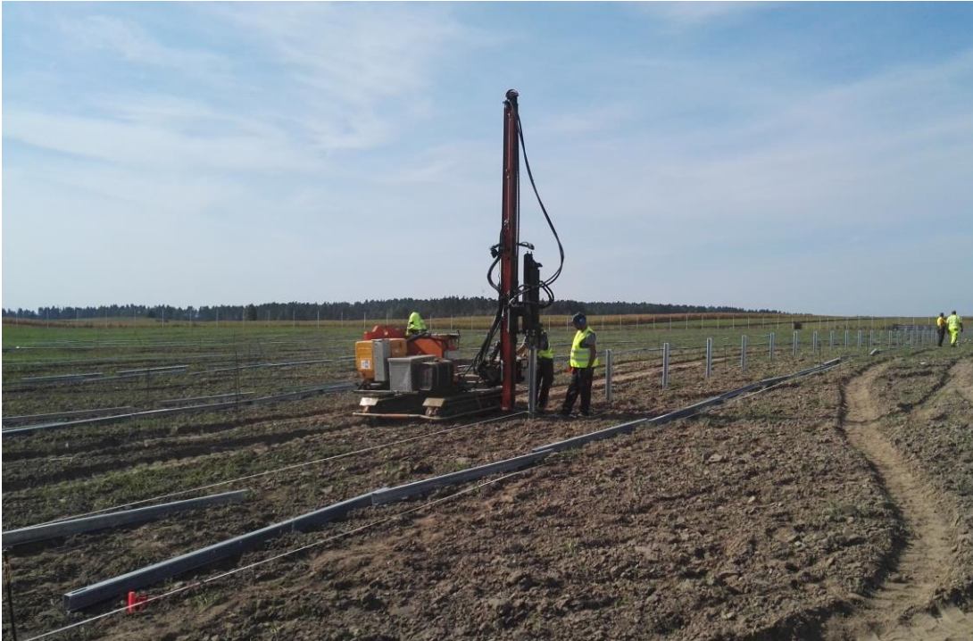
Rysunek 21 Kafar do wbijania profili nośnych
