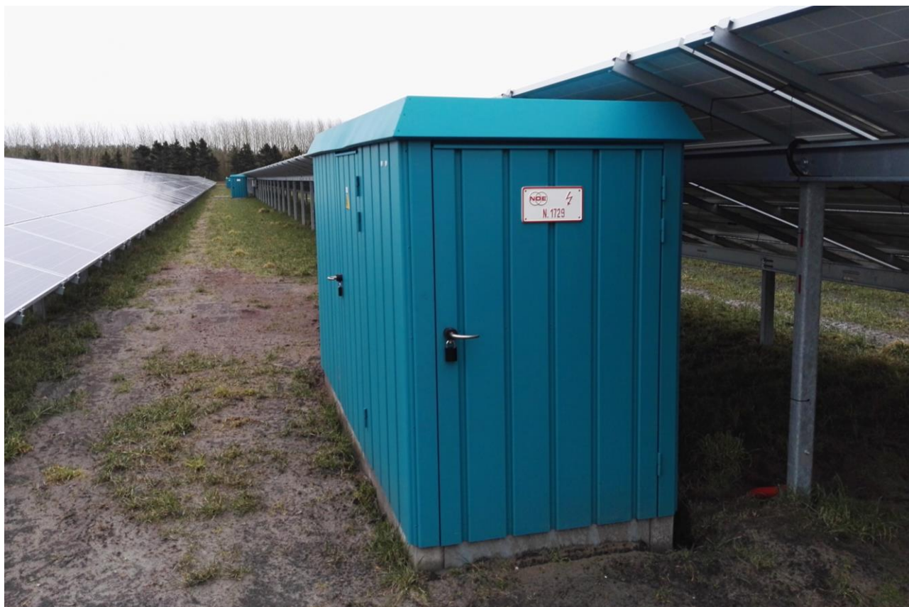
Rysunek 17 Obiekt stacji transformatorowej o mocy 0,5 MVA.
