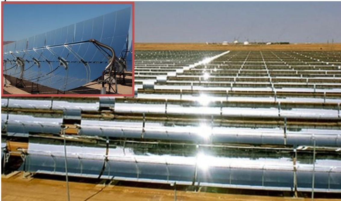
Rysunek 36 Lustrzane panele słoneczne (koncentratory)
