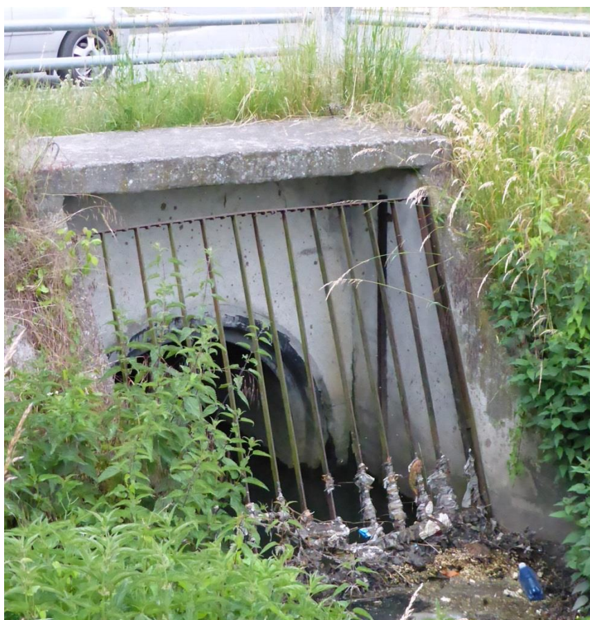
Przepust drogowy na cieku Sulechówka
