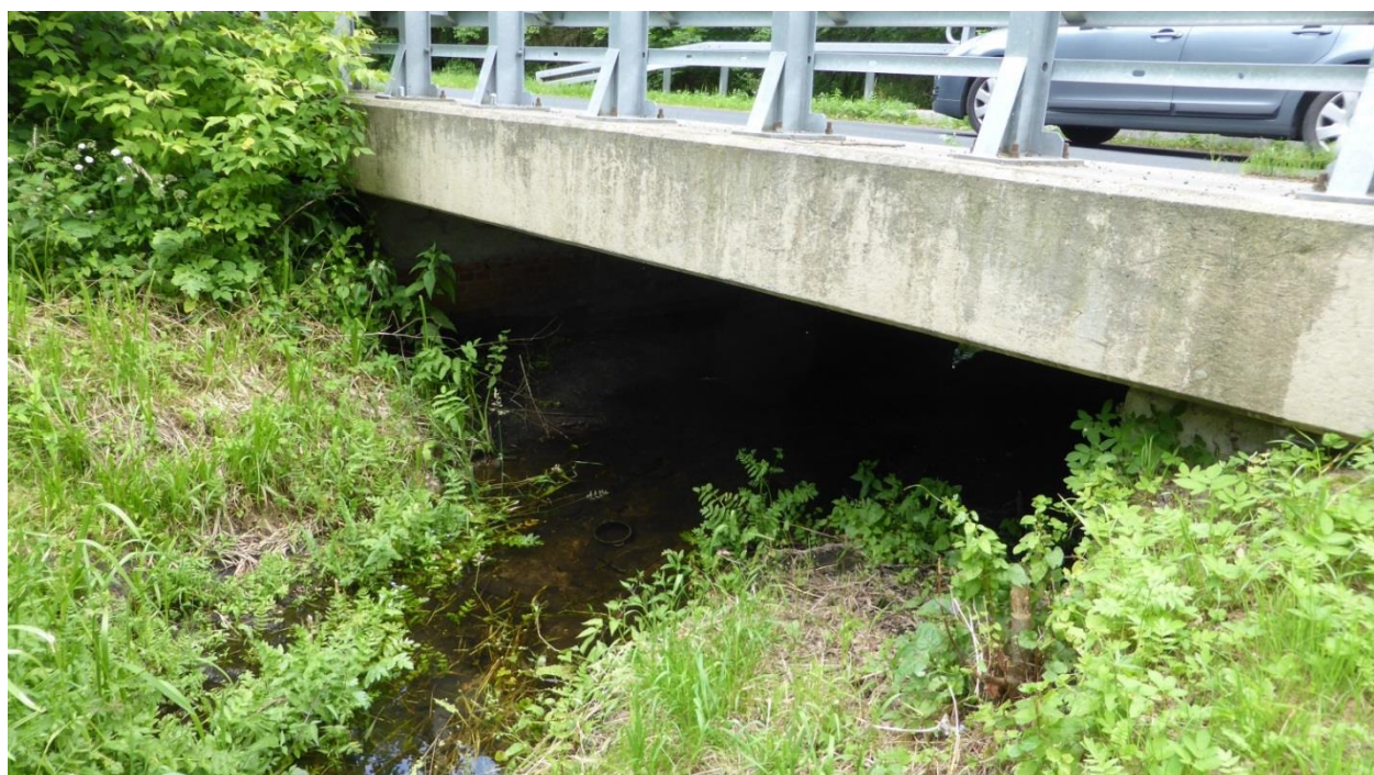
Przepust drogowy na rz. Jabłonna w rejonie Laskowa
