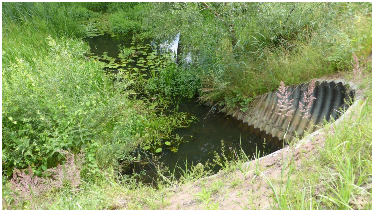
Przełaz drogowy na Kanale Pomorskim w m. Brody
